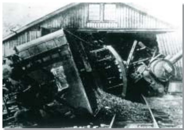
関東大地震による安房北条機関庫の被害
